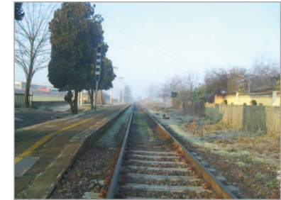
Figura 1.15 - T tratto ferroviario in prossimità dell'ingresso nel centro abitato
