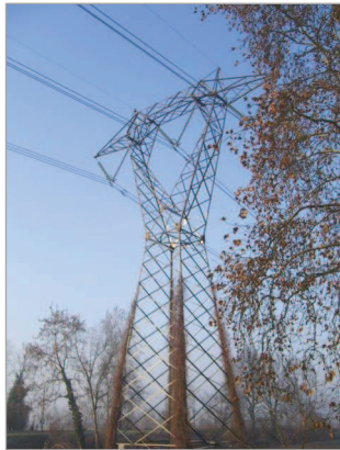
Figura 1.17 - L'elettrodotto linea 380 KV a sud dell'abitato
